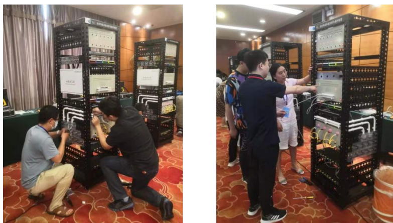
图 10 “综合布线系统永久链路搭建与测试”技能实训
