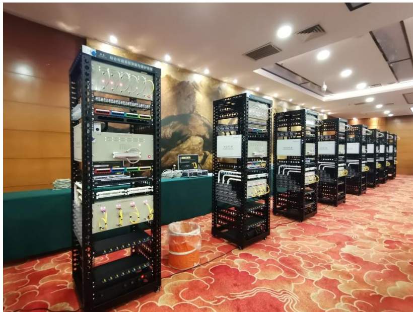
图 11 综合布线系统安装与维护实训室
